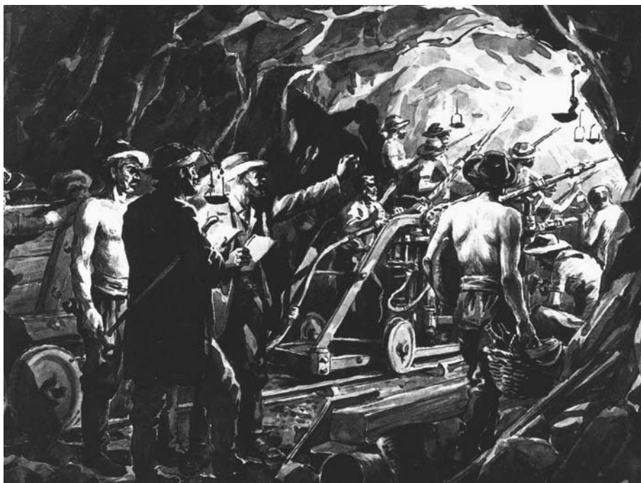
Abb. 3: Bohrarbeiten am Gotthard-Bahntunnel.
