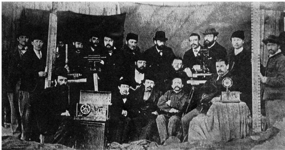
Abb. 1: Die Vermesser am Gotthard-Bahntunnel.
