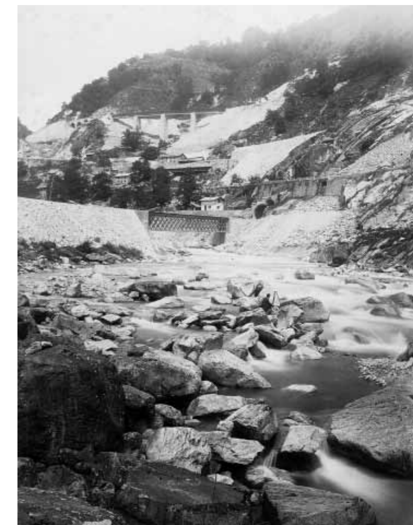
Kehrtunnelanlage in der Biaschina während der Bauzeit. – Bild: SBB Historic – Stiftung Historisches Erbe der SBB
